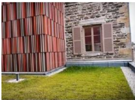
Toiture végétalisée (source : Grand Lyon)
