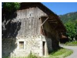
Hangar en bois bauju typique avec soubassement en pierres et grande avancée de toit - La Chapelle Saint Maurice. Photo PLUI RGLA
