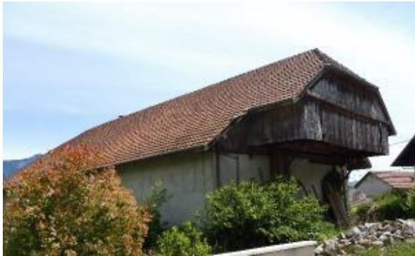
Forte avancée de toit sur le mur pignon augmentant la surface de stockage – ferme à Charvonnex (Doucy)
