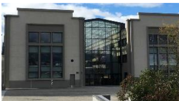
Contrevents des 2 travées du hall de l'ancienne papeterie Aussédats - Cran-Gevrier. Photo Ville d'Annecy
