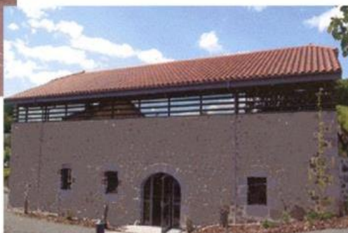
La transformation de cette grange respecte et réutilise les ouvertures anciennes pour éclairer une salle de réunion, placée en bas et créer une bande de vitrage sobre pour éclairer la bibliothèque, placée dans l'ancien fenil plutôt que de multiplier les fenêtr
