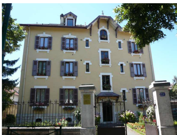
Petit immeuble Années 30-40
