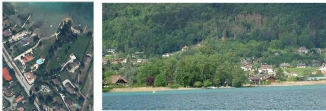
Figure 35 : Boisements situés au niveau de l'exutoire du ruisseau de la Planche - Sevrier
